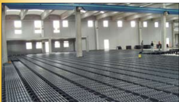
COLOSSEO in opera per pavimentazione industriale
