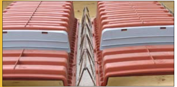
a travetti prefabbricati tralicciati (bausta)
