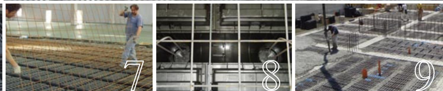
Fasi di montaggio dei componenti (1,2,3 e 4), posa in opera (5 e 6), armatura (7 e 8) e getto di calcestruzzo (9)
